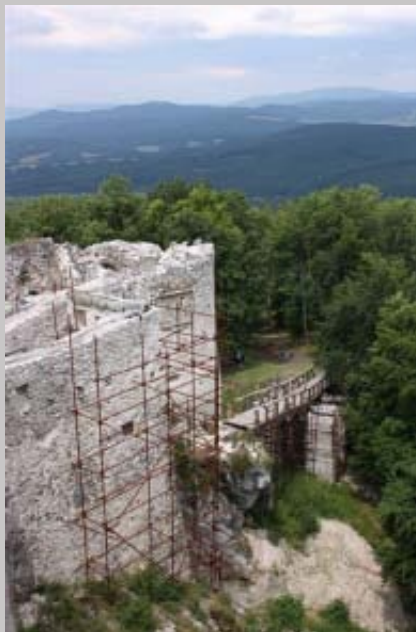
Pohľad z výšky na vstupný most
